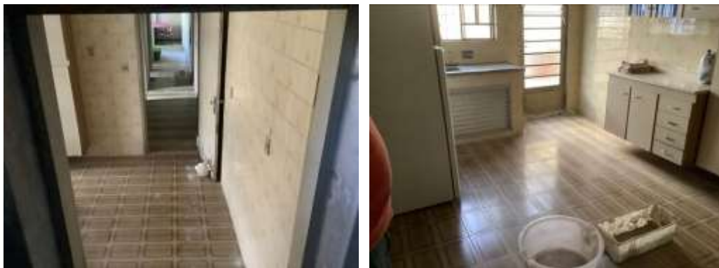
Vista corredor de acesso unidade da frente e cozinha.
