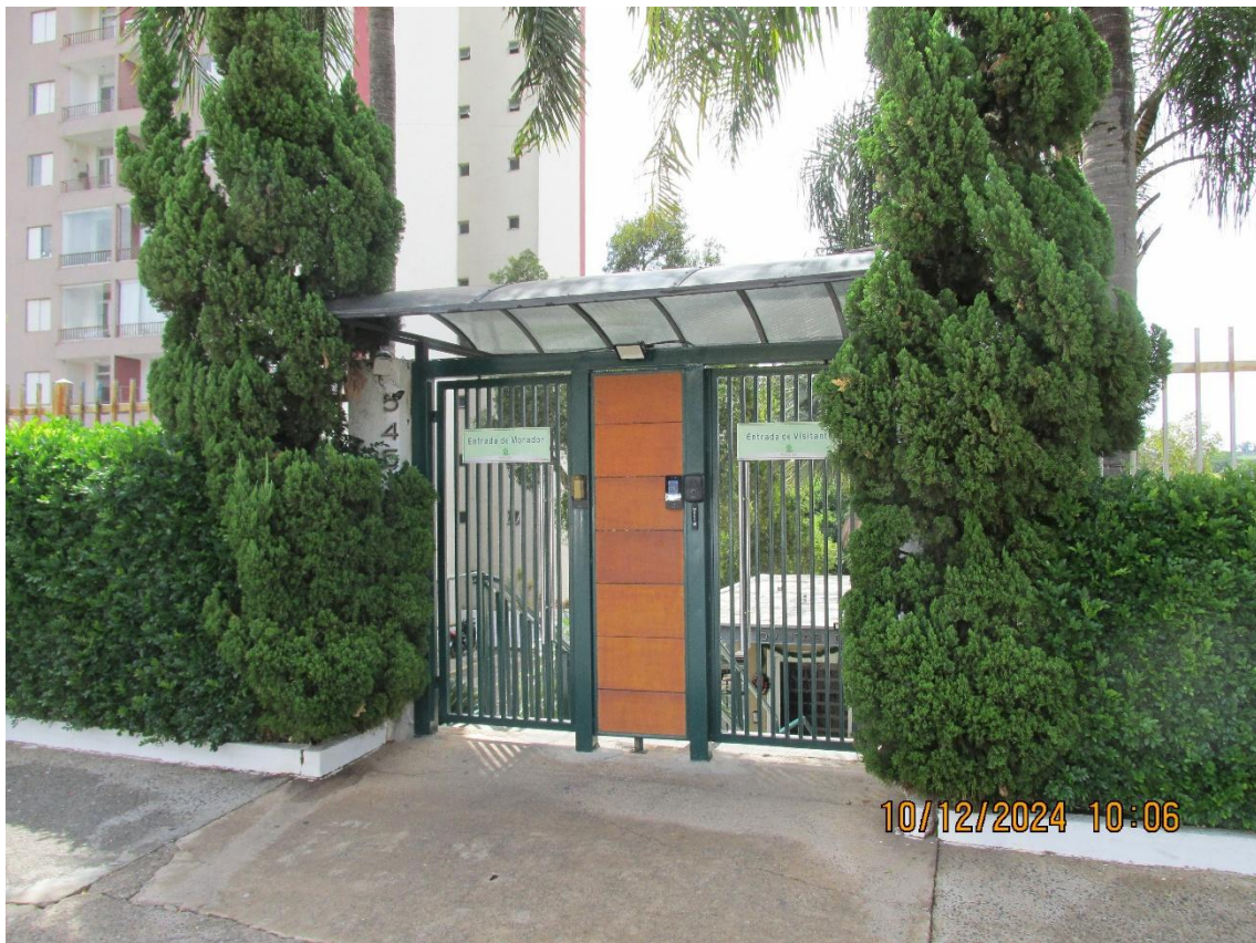
Fachada da Portaria e Identificação do Condomínio
