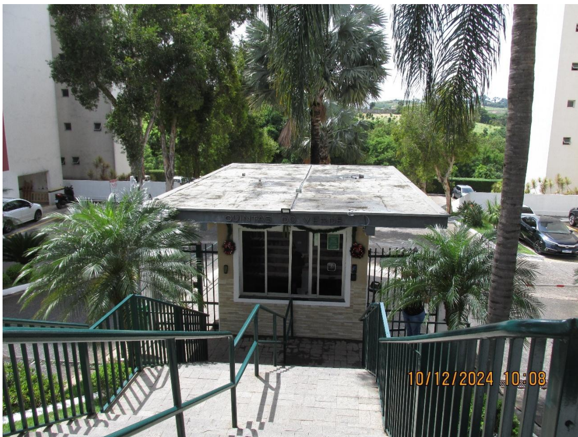
Fachada da Portaria e Identificação do Condomínio
