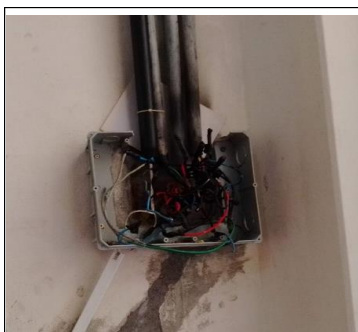
DET. INSTALAÇÕES ELÉTRICAS PRECARIAS
