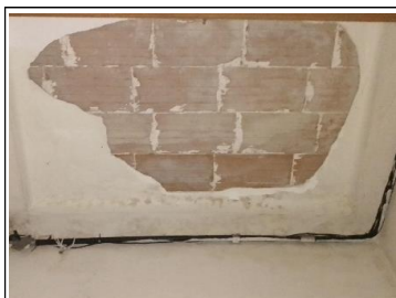
DET. INSTALAÇÕES ELÉTRICAS PRECARIAS
