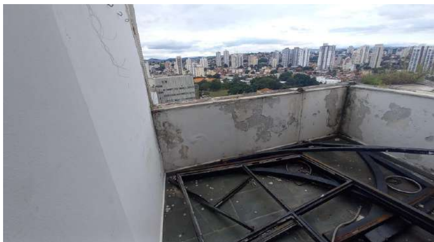
Foto 40. Vista da varanda do imóvel avaliando – pavimento superior
