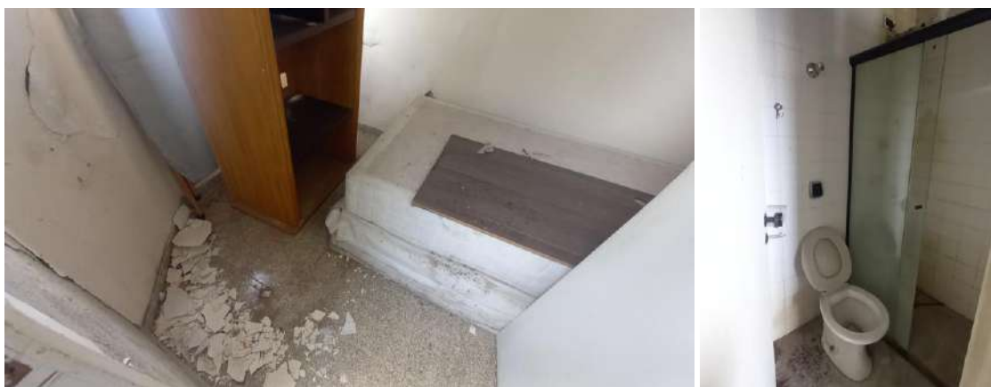
Fotos 17 e 18. Vistas do quarto e banheiro de empregada do imóvel avaliando
