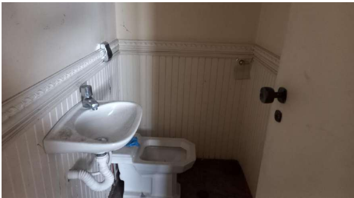
Foto 14. Vista do lavabo do imóvel avaliando
