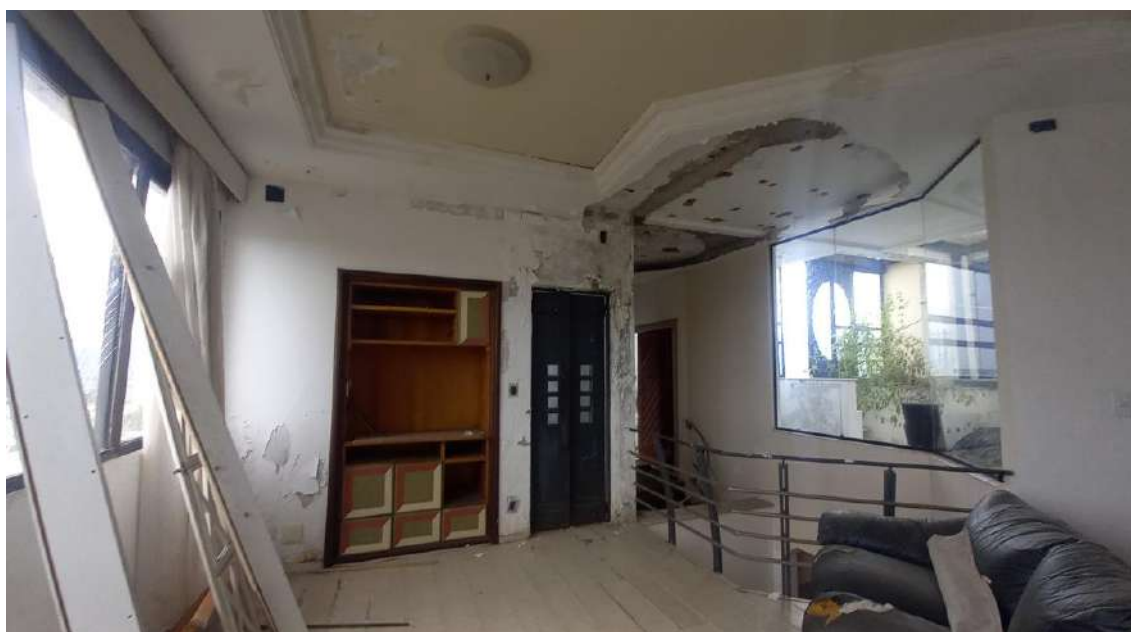
Foto 34. Vista da sala de TV do imóvel avaliando – pavimento superior
