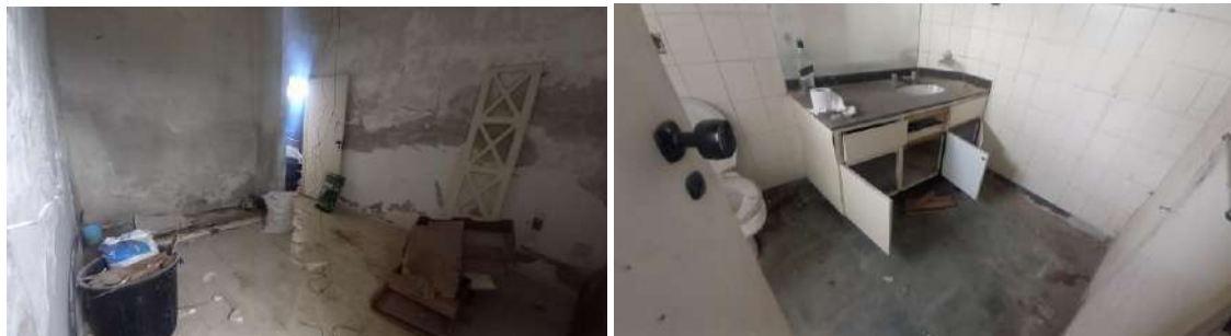
Fotos 32 e 33. Vistas da suíte 04 do imóvel avaliando – pavimento superior
