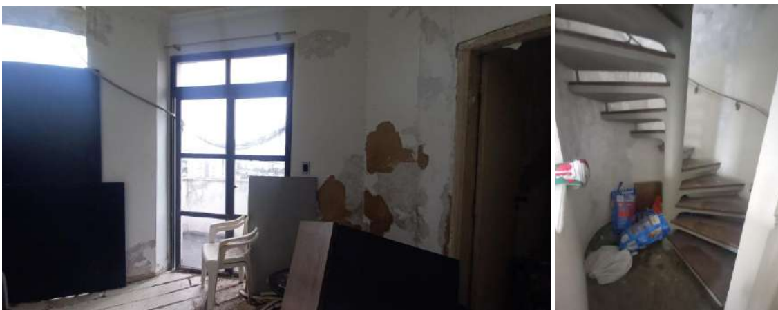
Fotos 30 e 31. Vistas da antessala e escada de acesso ao pavimento superior do imóvel avaliando
