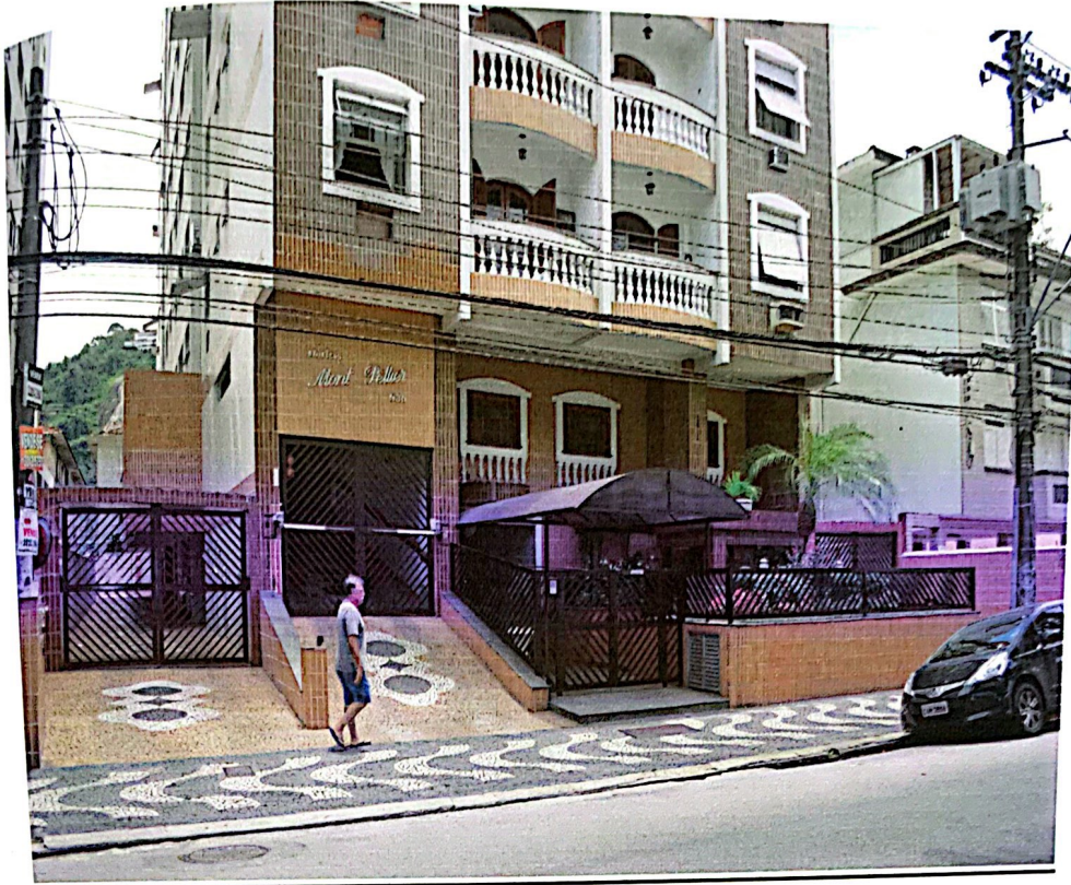
FOTO 03: Vista dos acessos.
