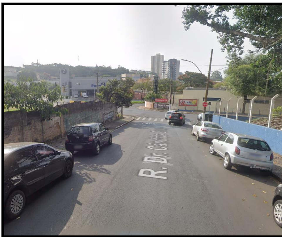
Figura 8 - infraestrutura urbana – Av. Dr Cândido Cruz
