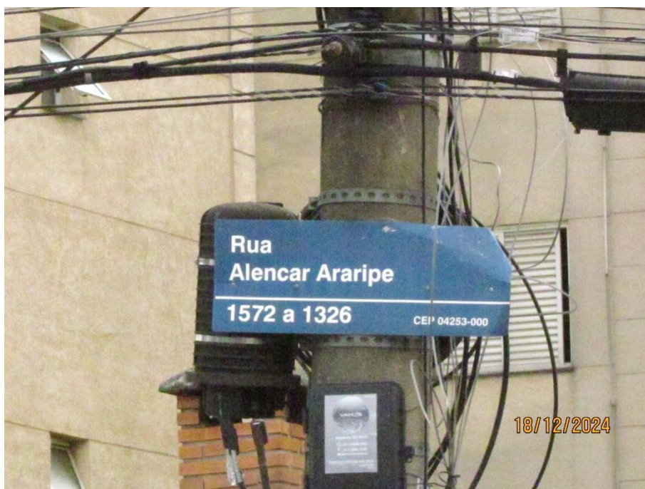
9- Detalhe da placa de identificação do logradouro;
