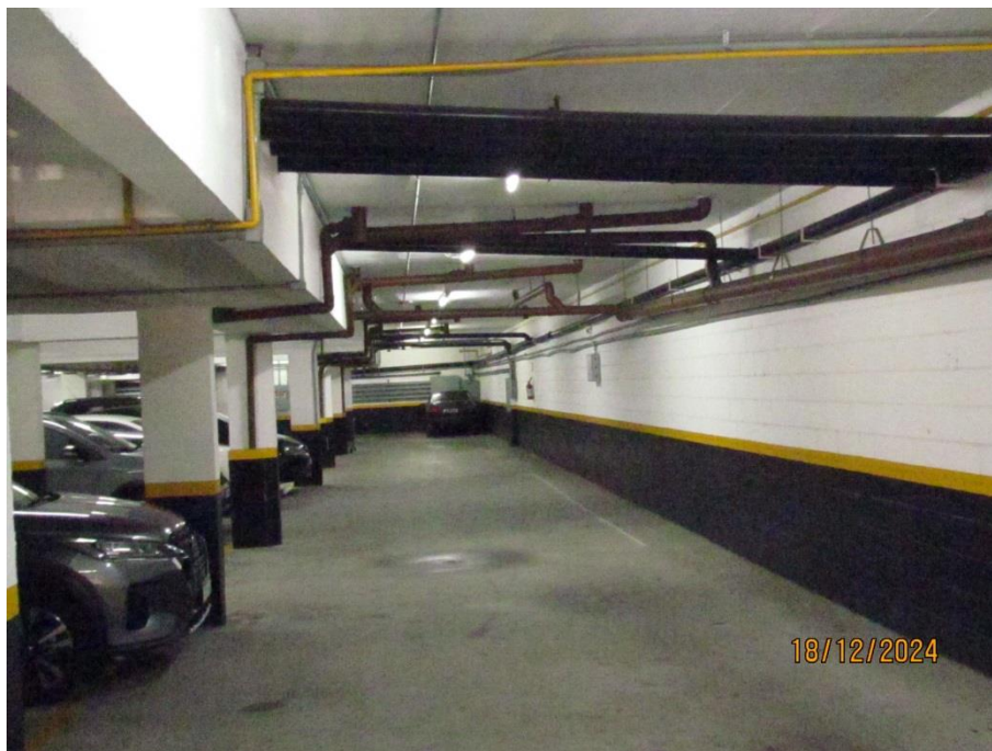
51 - Detalhe do Subsolo;
