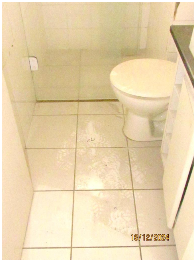
20 – Detalhe do banheiro;
