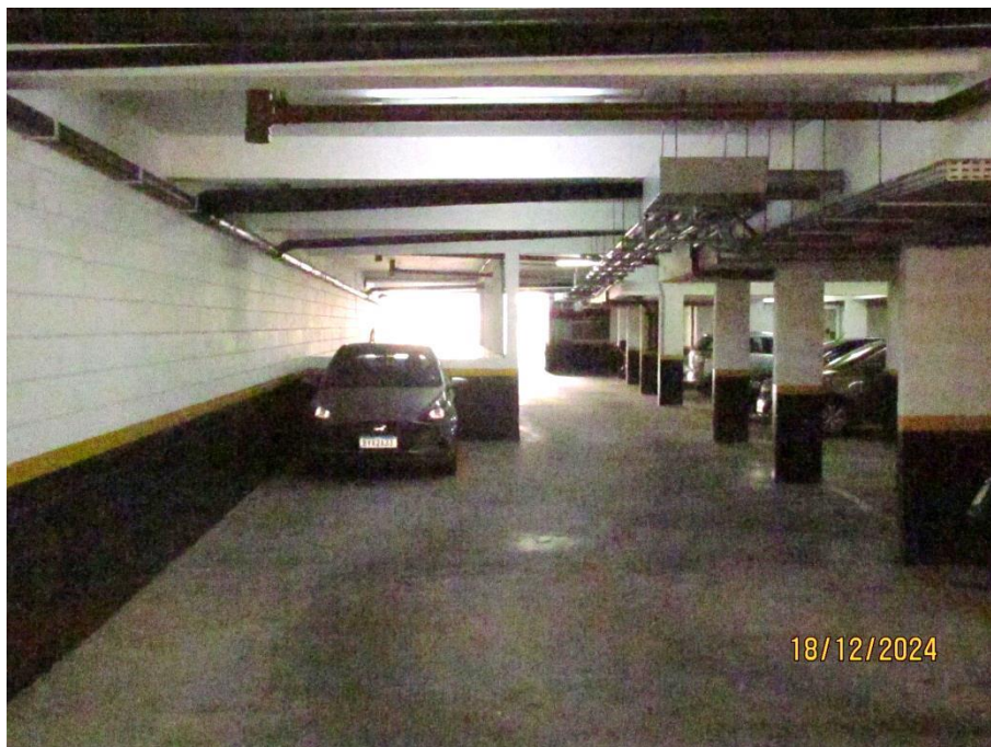
50 – Garagens do condomínio;
