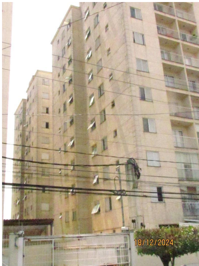
4 – Fachada lateral esquerda, de quem da rua olha, do Edifício Pinhal I;
