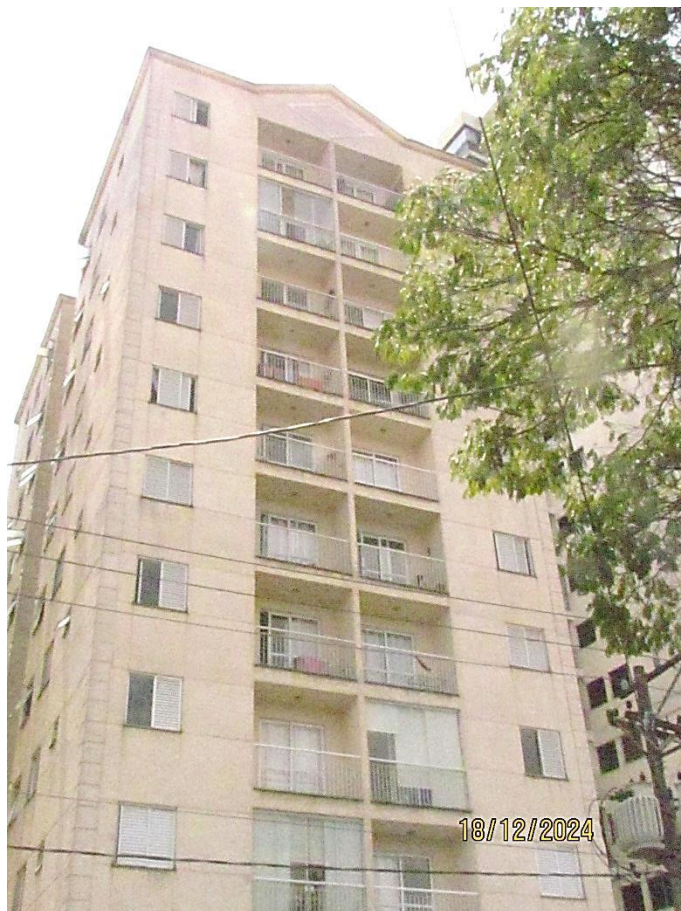
3 – Fachada frontal do Edifício Pinhal I;
