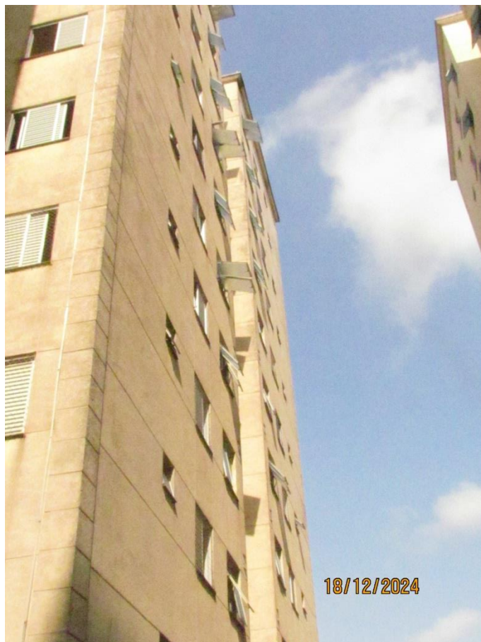
45 – Detalhe da fachada lateral;
