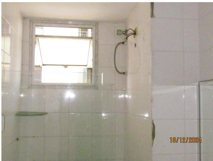
22 – Detalhe do Box do banheiro;
