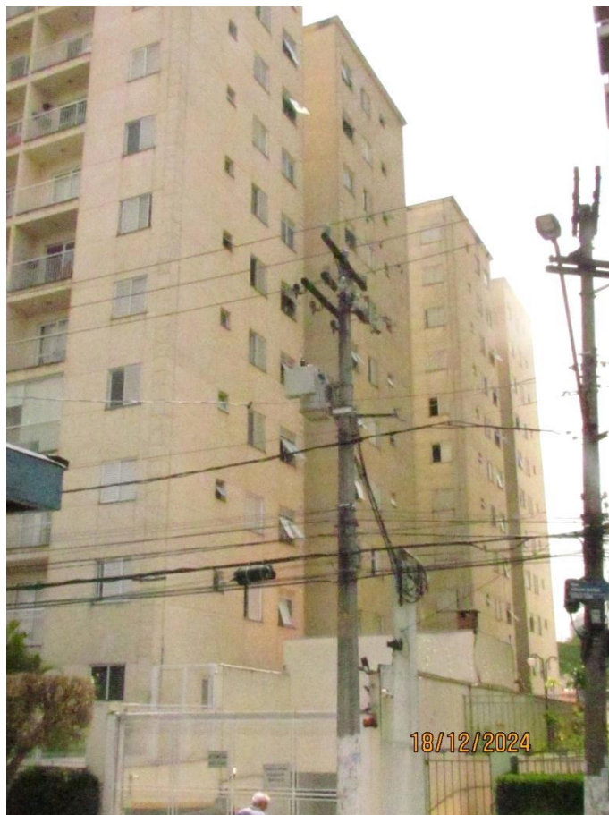
5 – Fachada lateral direita do Edifício Pinhal I;
