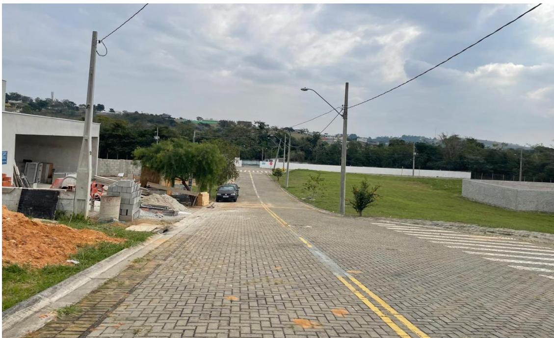
Foto 06. Via de acesso ao Lote 11 da Quadra D
