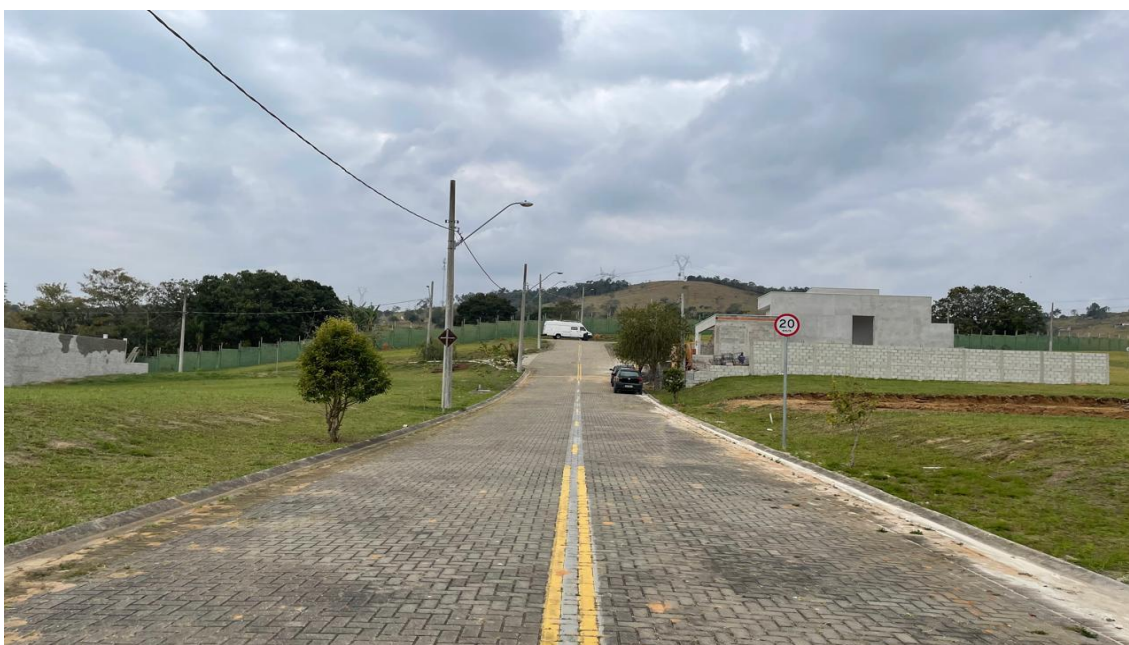
Foto 07. Via de acesso ao Lote 11 da Quadra D
