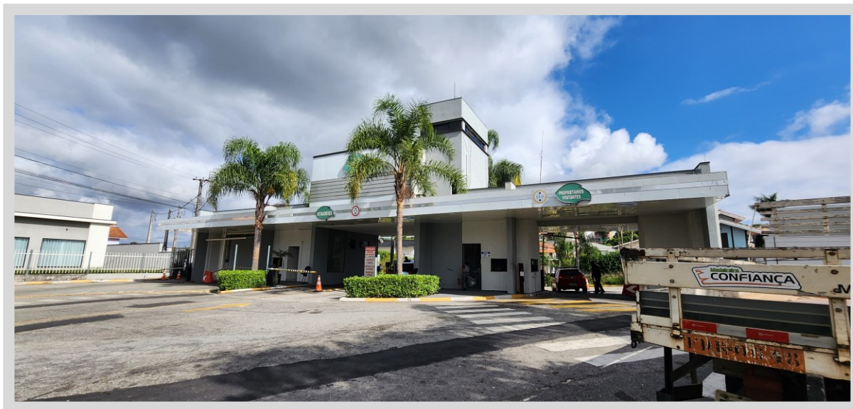
Portaria de acesso ao Residencial Eco Park Lagos.
