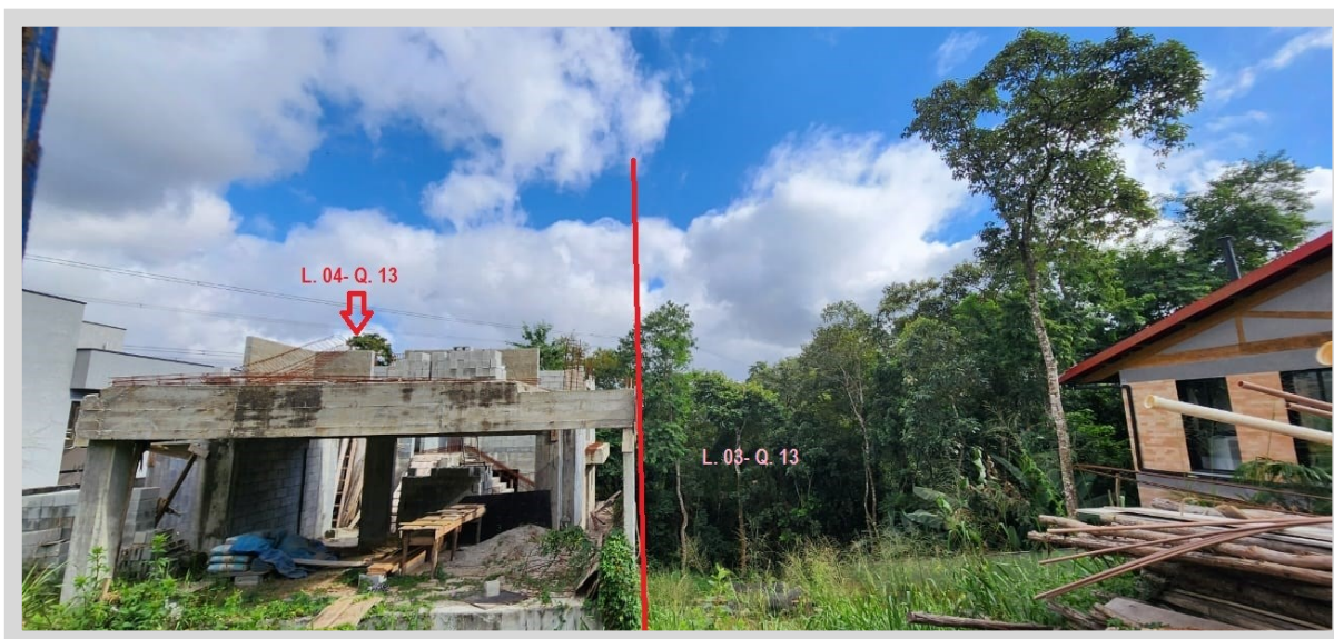
Construção iniciada sobre o Lote 04 da quadra 13 do Loteamento denominado “Residencial Parque dos Lagos” abandonada desde 2021 aproximadamente.
