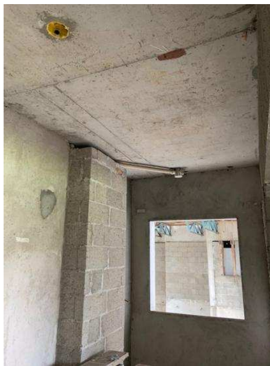
Foto 11. Vista de um dos banheiros da Torre 2. Vide aí, que Possi tubulação do sistema hidrossanitário instalada. Faltam acabamentos e instalação de esquadrias e rede elétrica. Situação se repete em todos os andares desta torre.
