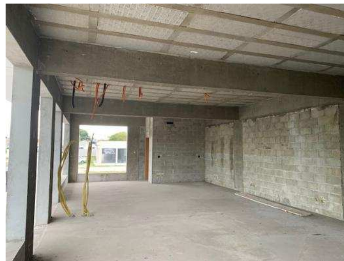
Foto 17. Vista de outra sala comercial, localizada no pavimento superior do bloco comercial. Vide aí, que faltam revestimentos, condutores da rede elétrica, e instalação de esquadrias.
