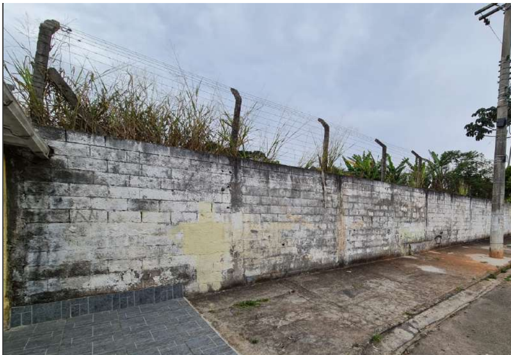
Foto 06 – Vista do imóvel pela Rua Giovani Beltramo.
