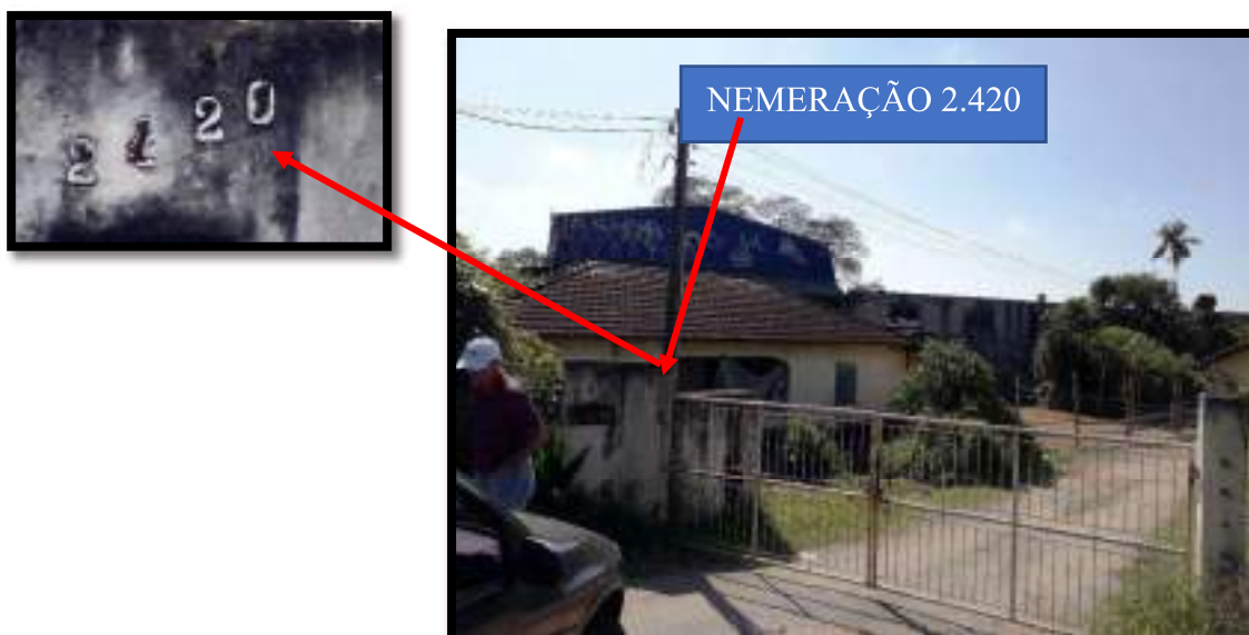
Foto 2 – Portão de acesso à gleba de matricula 44.440.
