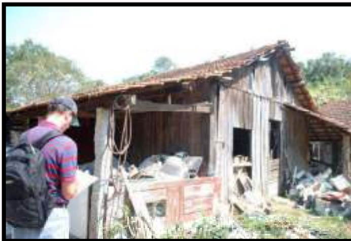
Foto 9 – Estado de conservação precário e estrutura de madeira já deteriorada.
