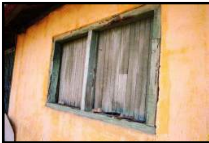
Foto 23– Visão externa do galpão, janela de madeira deteriorada
