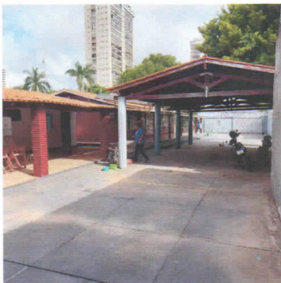
Foto 5 - Imóvel Avaliando - Rua Dom Mario Andreazza, 204. Três Poderes. 5°30'56.37° - 47°28'40.02°O
