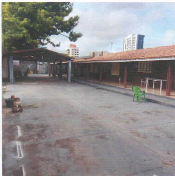
Foto 3 - Imóvel Avaliando - Rua Dom Mario Andreazza, 204. Três Poderes. 5°30'56.37° - 47°28'40.02°O
