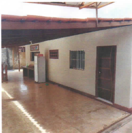
Foto 8 - Imóvel Avaliando - Rua Dom Mario Andreazza, 204. Três Poderes. 5°30'56.37° - 47°28'40.02°O
