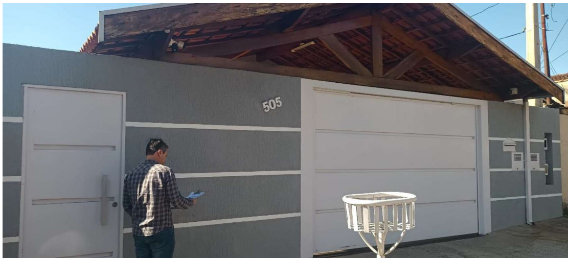
Figura 2 - Vista frontal do imóvel
