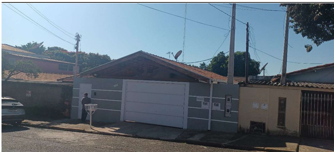
Figura 5 - Vista frontal do imóvel
