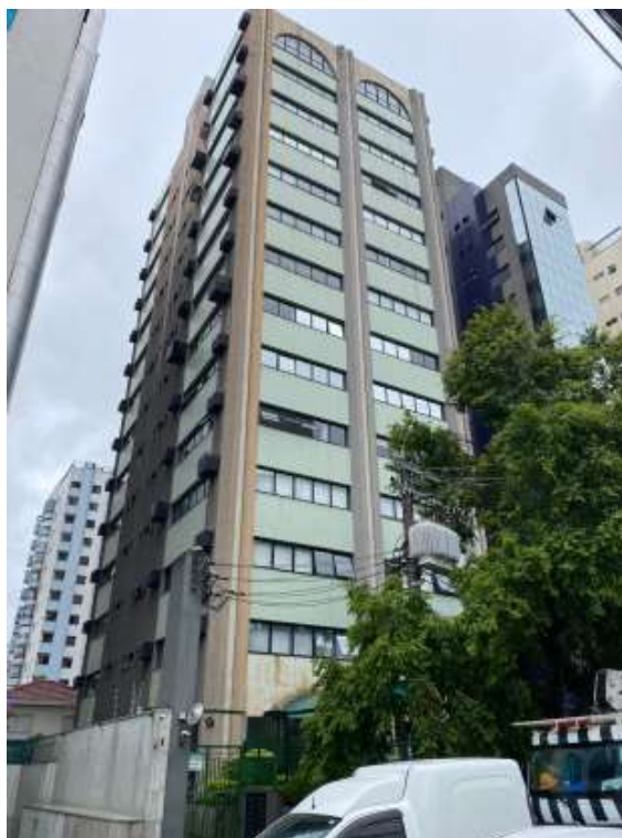
Foto 01 – Frente do imóvel avaliando, Rua Dr. Alceu de Campos Rodrigues, nº 247
