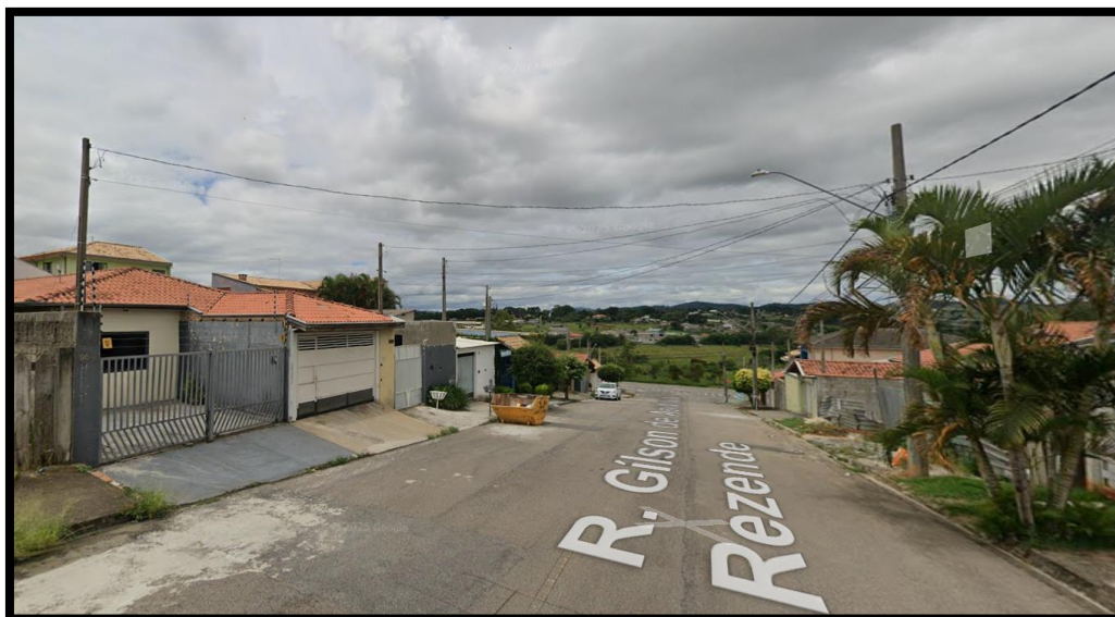
Figura 5 - infraestrutura urbana em frente ao imóvel
