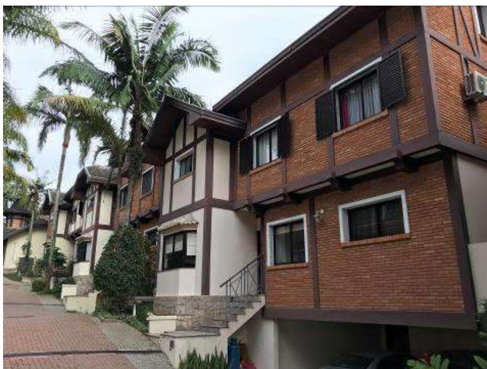
Aspectos de outras unidades situadas no Condomínio Villaggio Campos do Jordão, com destaque para as características construtivas.
