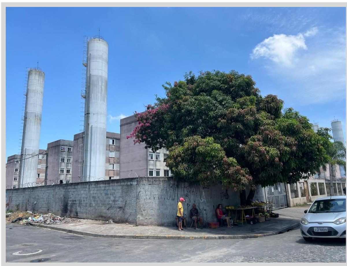
Condomínio Residencial Jundiapéba IV, classificado como: Edifício residencial, Grupo 1. 3 – Apartamento, 1.3.1-Padrão Econômico.
