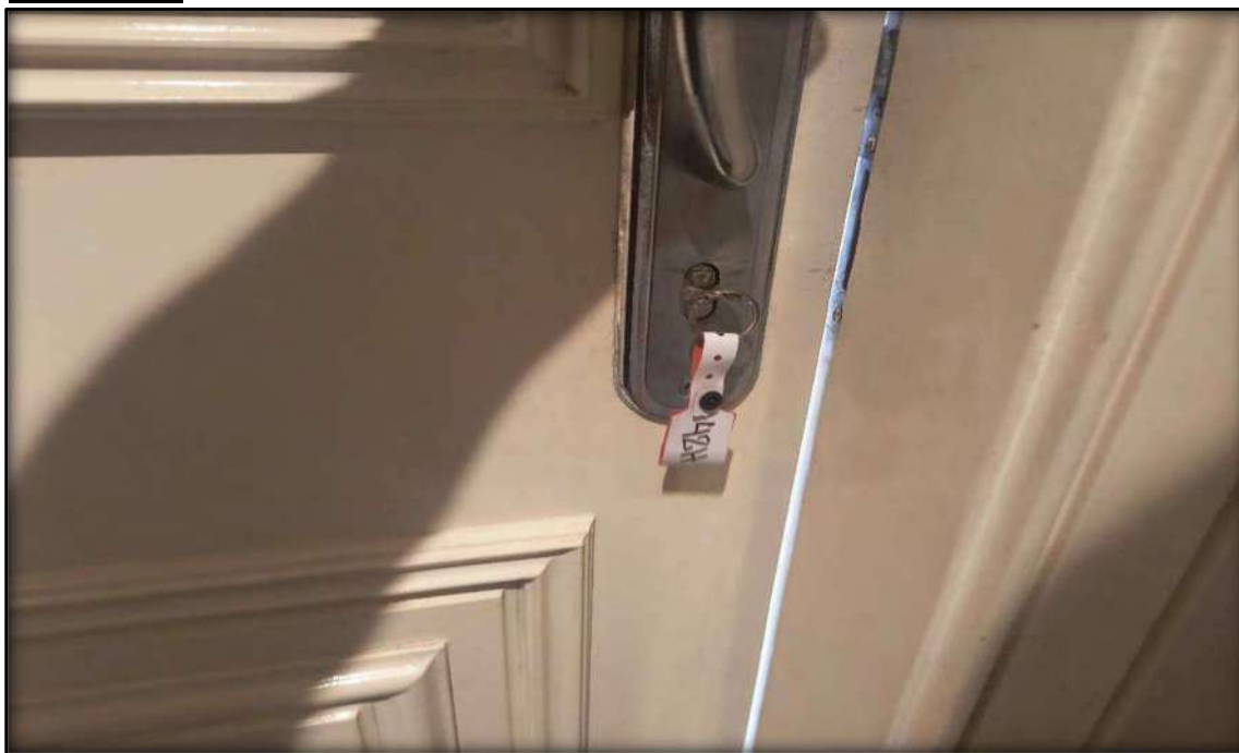
VISTA INTERNA DO EDIFÍCIO SOROCOTUBA III.
