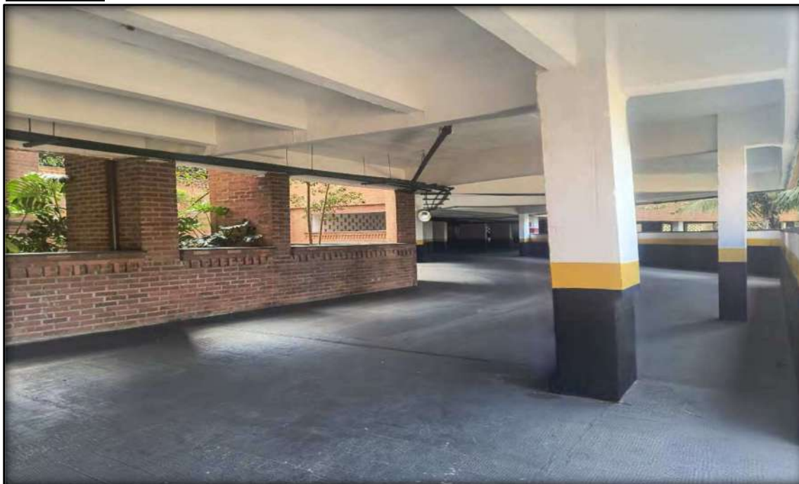
VISTA INTERNA DO EDIFÍCIO SOROCOTUBA III.
