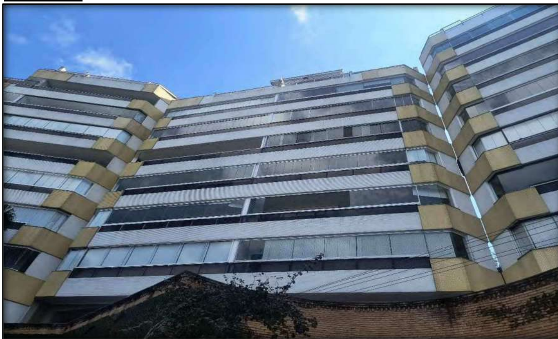
VISTA INTERNA DO EDIFÍCIO SOROCOTUBA III.
