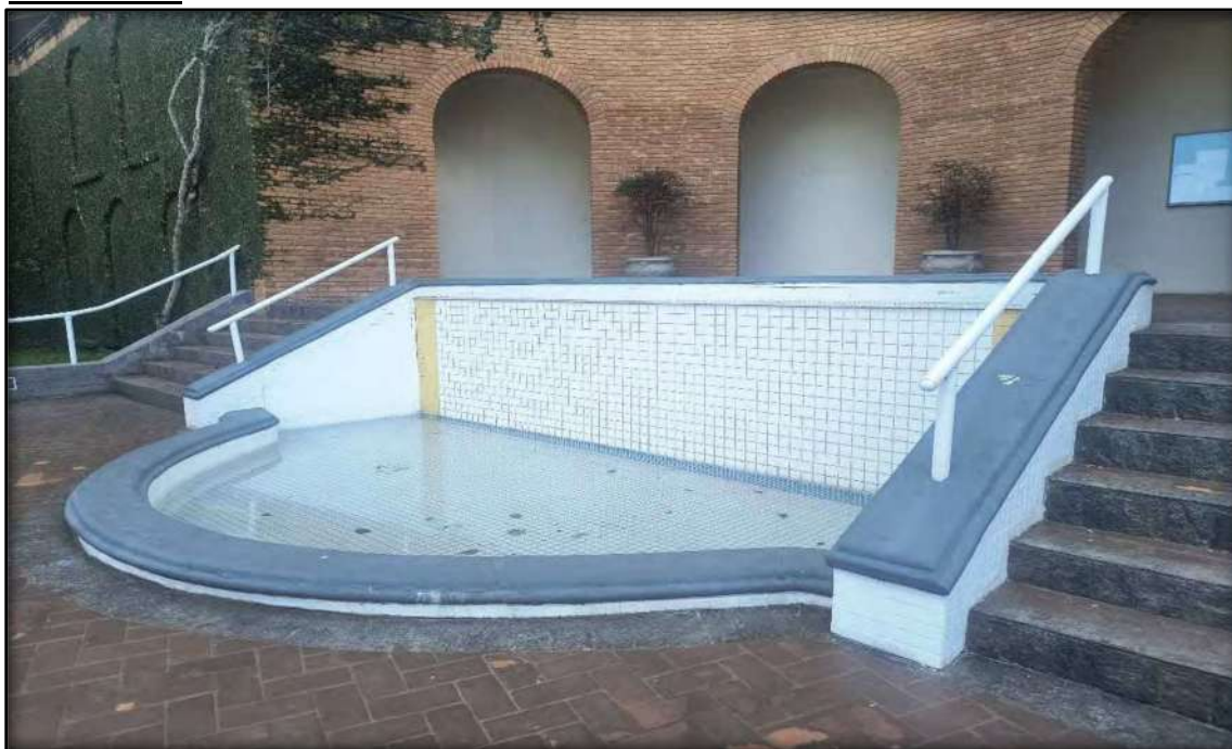
VISTA INTERNA DO EDIFÍCIO SOROCOTUBA III.
