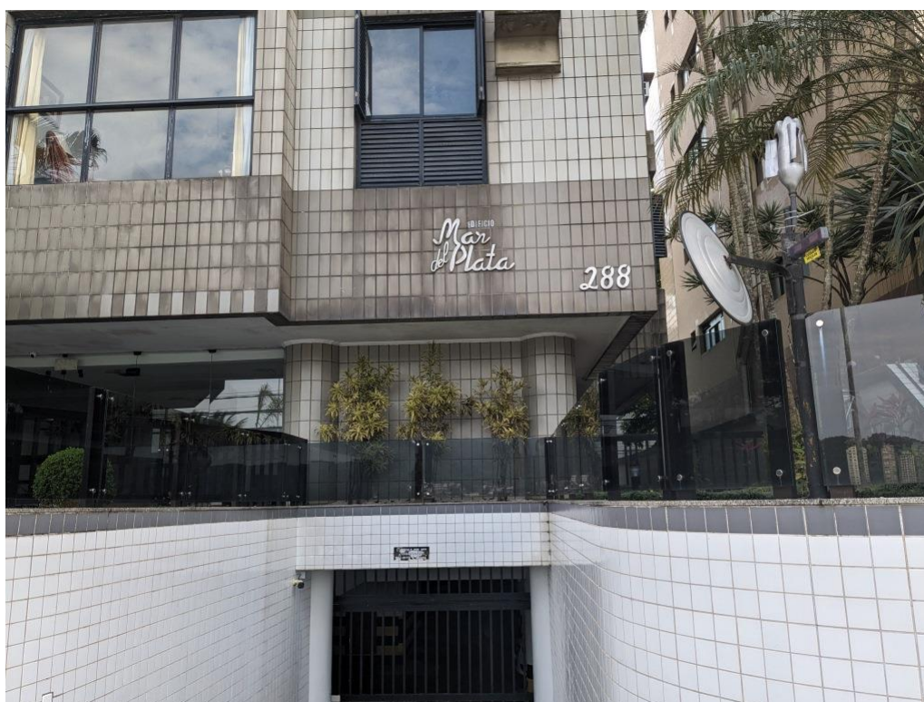
Foto 2 – Identificação e emplaceamento do edifício
