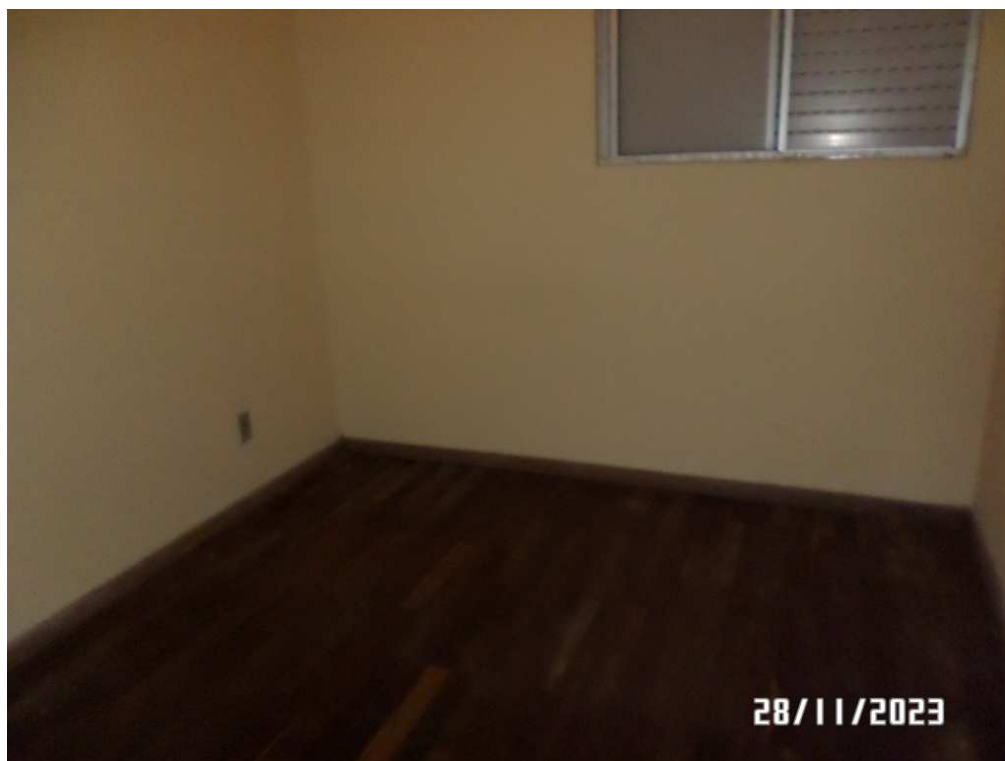
FOTO N º 10 – VISTA PARCIAL DORMITÓRIO 3.
