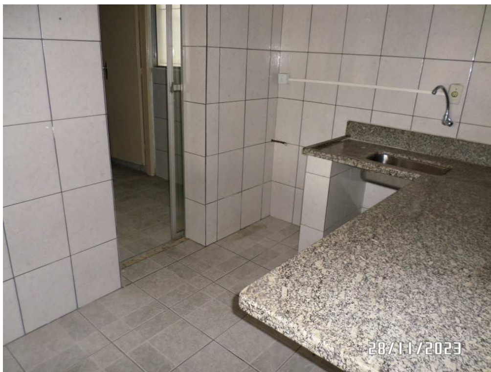
FOTO N ° 05 – VISTA PARCIAL COZINHA.
