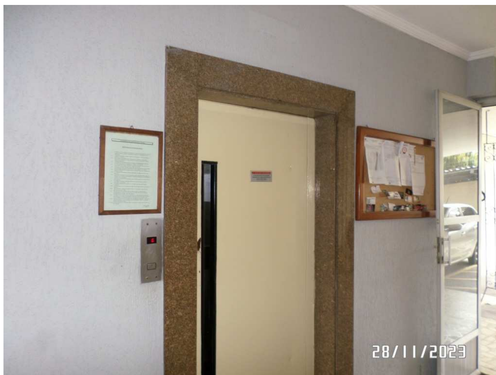
FOTO N ° 14 – VISTA PARCIAL HALL DO ELEVADOR - TÉRREO.
