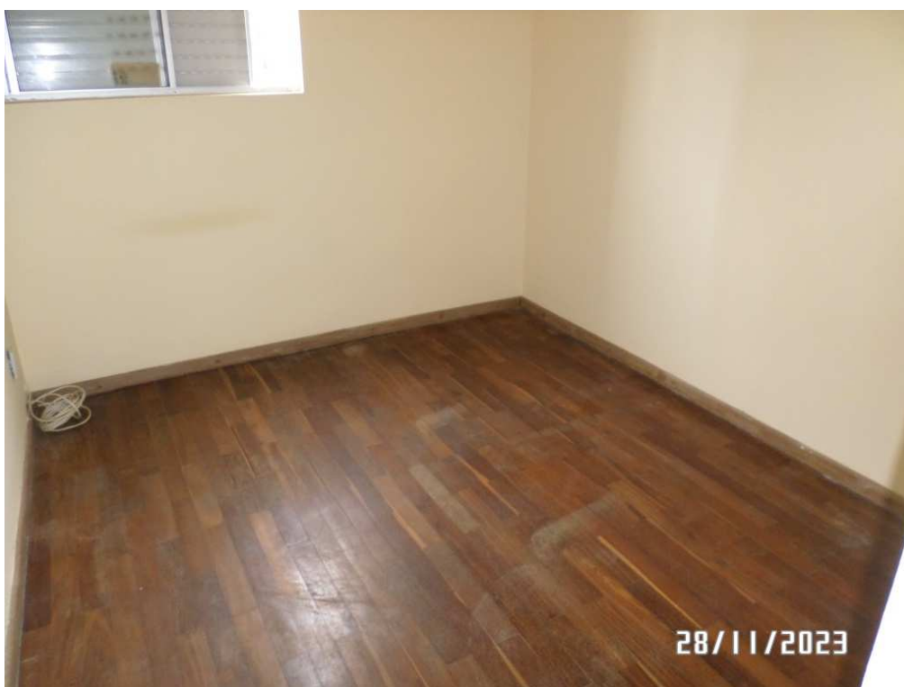
FOTO N º 09 – VISTA PARCIAL DORMITÓRIO 2.
