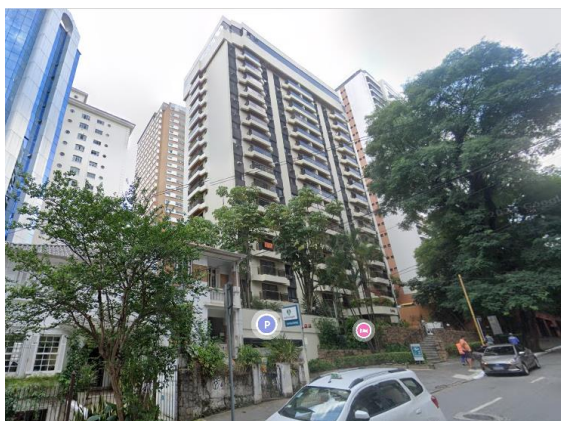
Foto da fachada
