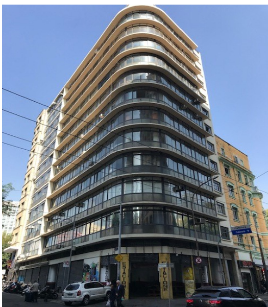
Foto 1 - Fachada do Prédio
