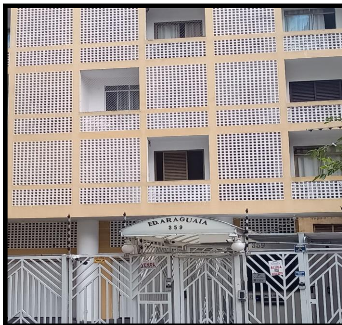
Vista da Portaria do Edifício Araguaia.
