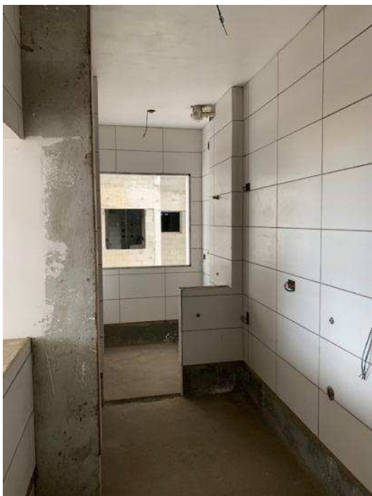
Foto 07. Vista da cozinha de um dos apartamentos da Torre 1. Vide aí que foi instalado revestimento cerâmico, executado contrapiso e passados eletrodutos e condutores da rede elétrica. Não foi instalada esquadria, e faltam detalhes de acabamento. Situação repete-se do 4º ao 12º pavimento.
