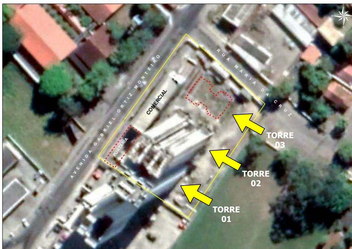
Figura 3. Vista da situação existente “in loco”, onde é possível observar as torres 01 e 02 e o bloco comercial do empreendimento em tela, que foram construídos, porém não encontram-se concluídos. Vide aí também, os polígonos tracejados em vermelho, que indicam o local da Torre 3 e portaria, as quais não foram construídas. Imagem do satélite QuickBird datada de julho de 2020 (fonte Google Earth).
