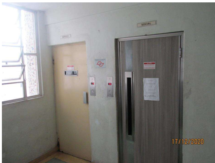
Foto 19 - Elevadores social e serviço só param nos andares intermediários
