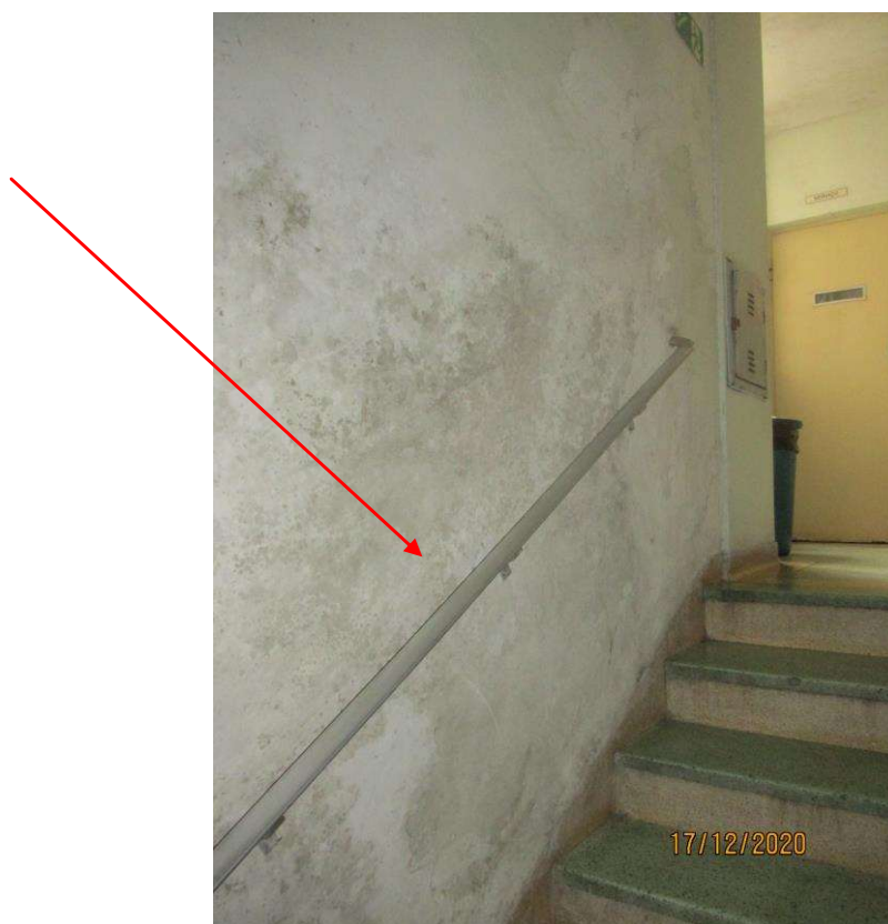
Fotos 17 e 18 - Manchas escuras devido as infiltrações nas paredes e tetos dos corredores de circulação e escadarias – áreas comuns
