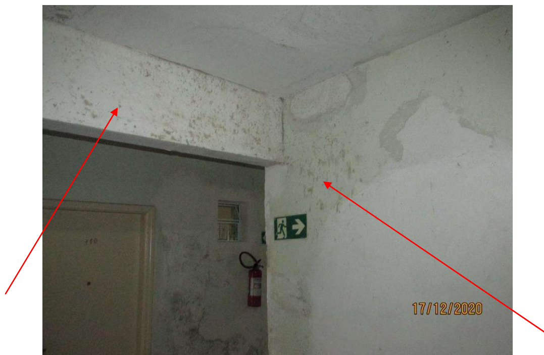
Fotos 17 e 18 - Manchas escuras devido as infiltrações nas paredes e tetos dos corredores de circulação e escadarias – áreas comuns
