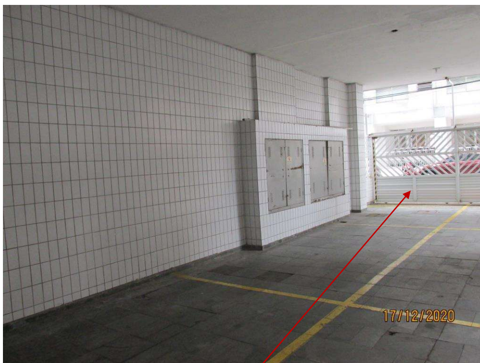
Foto 7 - Garagem no térreo e acesso pela Rua Benedito Calixto
