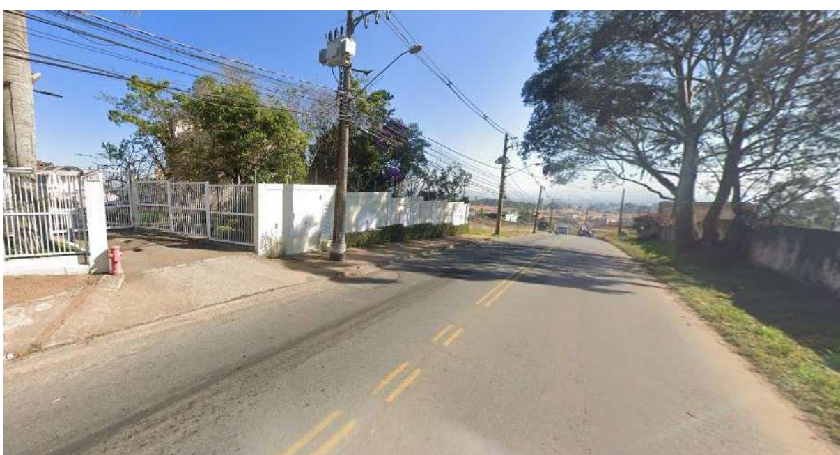
Figura 2 – Avenida Manoel Casanova
