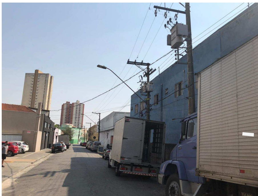
OUTRO LADO DA VIA PANAMÁ, ONDE SE LOCALIZA O IMÓVEL.
