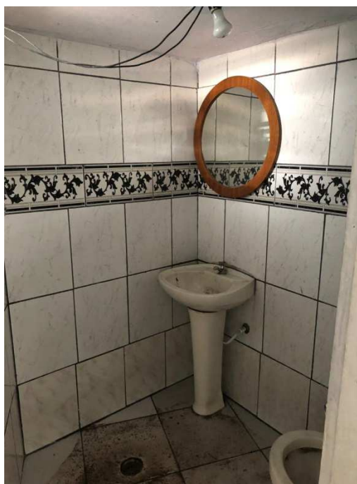
VISTA DO BANHEIRO, CONSTRUÇÃO NA ÁREA DIVERSA DO LOTE AVALIANDO.
