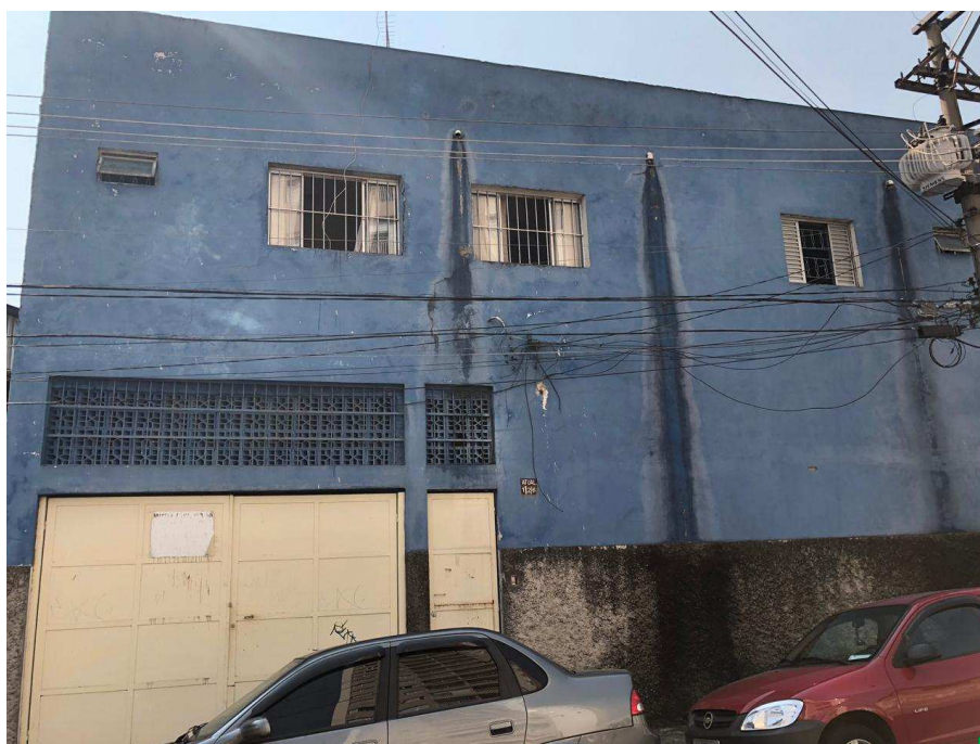
VISTA DA ENTRADA DO IMÓVEL ACESSO PELA VIA PANAMÁ.
