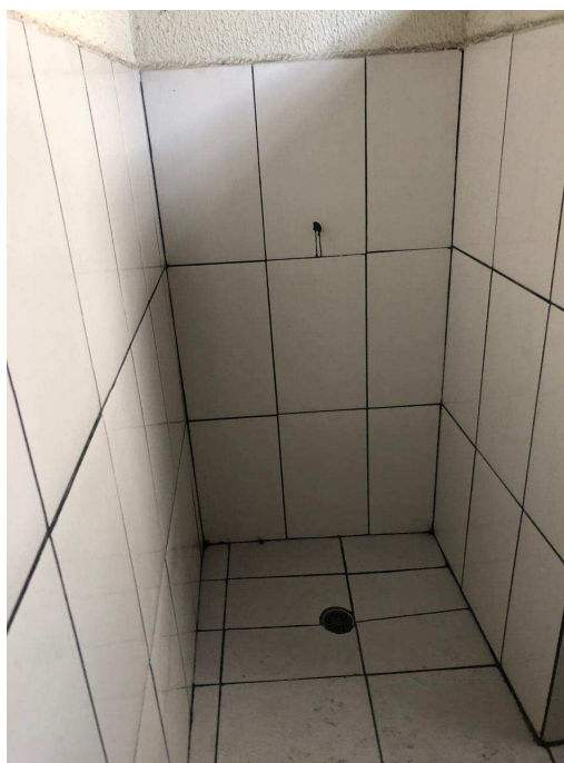
VISTA DO BANHEIRO.
