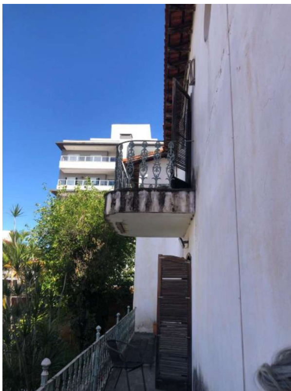
MESMA VARANDA, VENDO-SE ACIMA A VARANDA DE UMA DAS SUITES SITUADAS NO PAVIMENTO SUPERIOR
