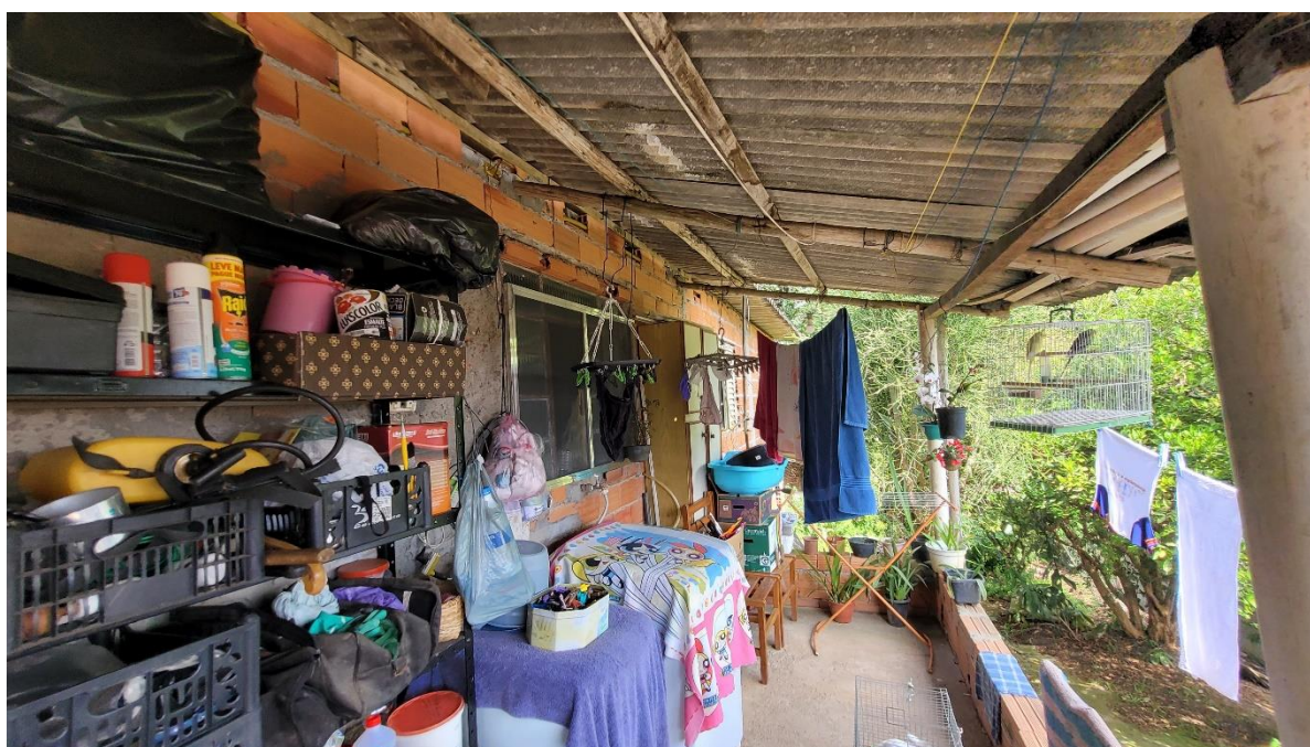
Vista parcial da meia água (edícula)
