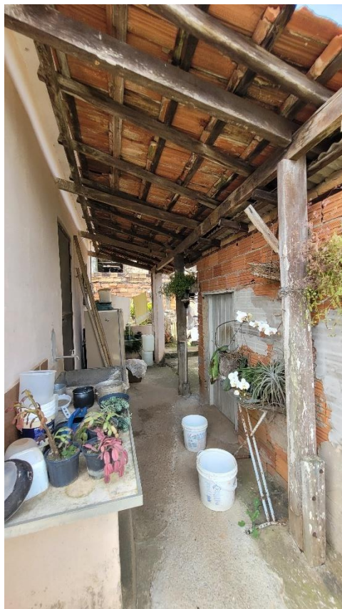
Vista fundo da residência.
