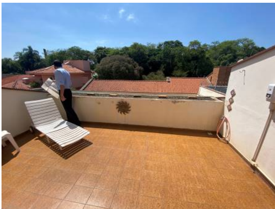
VISTA DA VARANDA.
