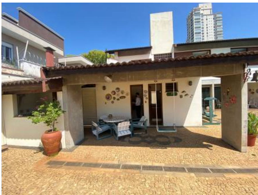
VISTA DA COBERTURA.
