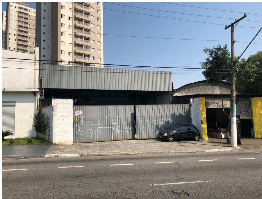
VISTA DA FACHADA DO IMÓVEL COM ACESSO PELA AVENIDA FIRESTONE.
