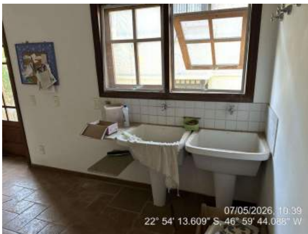
FOTO 28 – TÉRREO – ÁREA DE SERVIÇO
