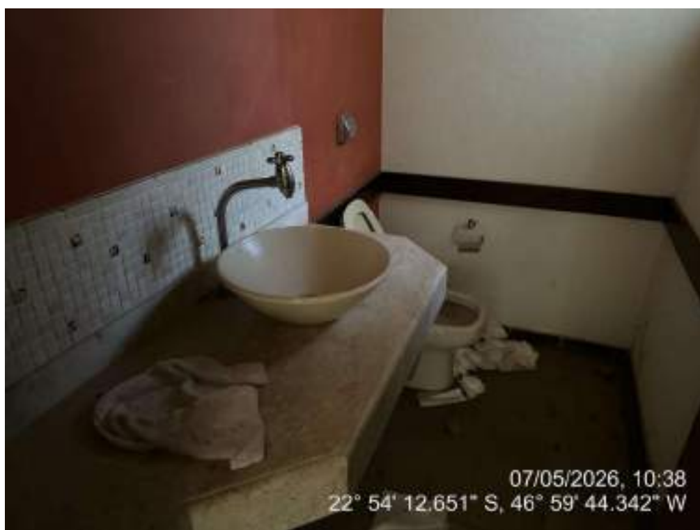
FOTO 24 – TÉRREO – BANHEIRO SOCIAL 1
