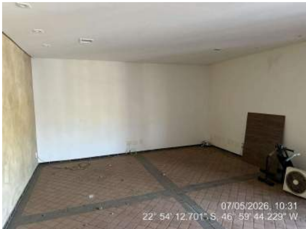
FOTO 14 – PAV. INFERIOR – SALA
