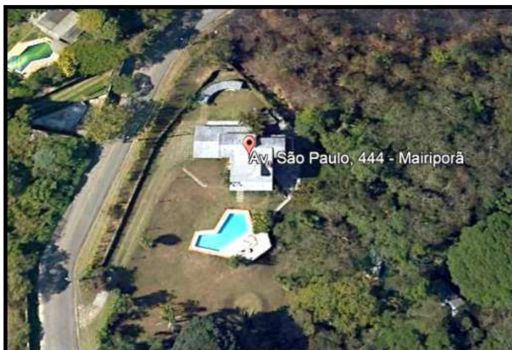
GoogleEarth - Av. São Paulo, 444 - Parque Petrópolis - Mairiporã/SP
